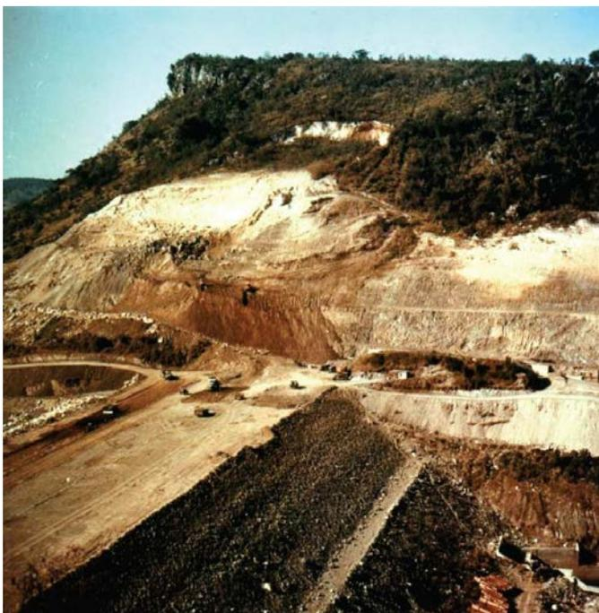
La ubicación del eje de la presa al lugar del valle el más estrecho, no siempre significa que se va a construir sin los problemas. Deslizamiento de las calizas del paleógeno en el eje de la presa Guisa, Cuba. Foto Otto Horsky, 1980.
