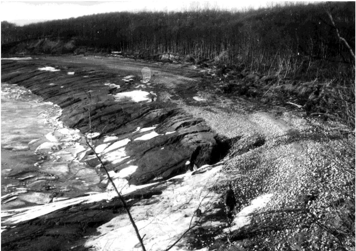
Abrasión de las orillas y sucesivos deslizamientos en rocas del neogéno, presa Orava, 1968.
