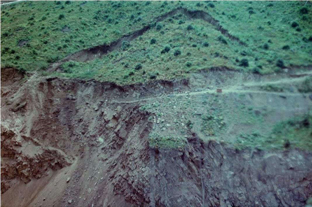
Derrumbe de la margen derecha de Dalešice, provocado por abrir el valle hasta la profundidad de los 20 metros, para ubicar las tuberías. No se ha respetado el proyecto de realizar antes de la apertura los anclajes. 1972
