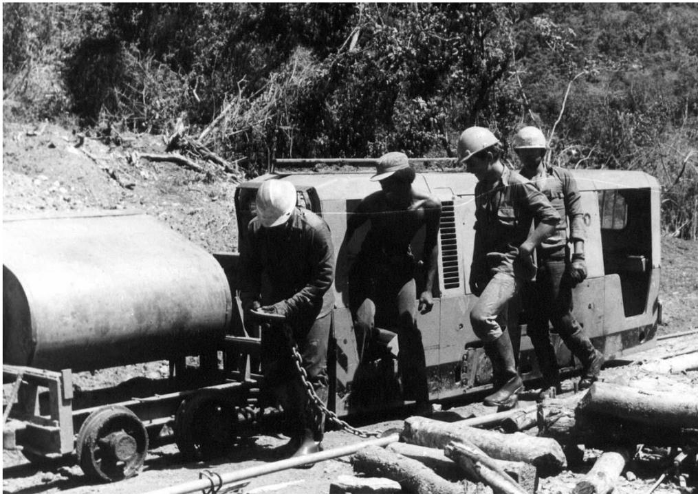
Para el transporte de material excavado de las galerías sirvieron locomotoras y excavadoras de la tecnología checoslovaca, 1985.
