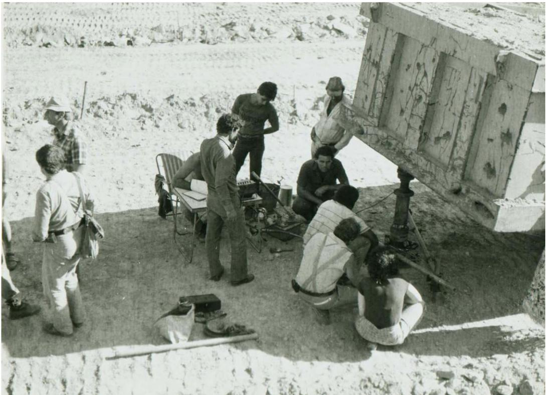
Prueba de carga de placa en terraplen de prueba en el Embalse Superior, 1986.
