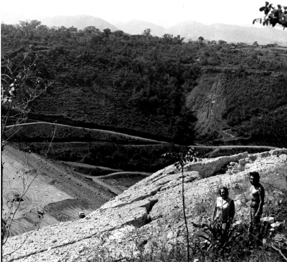
Derrumbe en Guiza puso en peligro los trabajos de la construcción. Estado en 1981.
