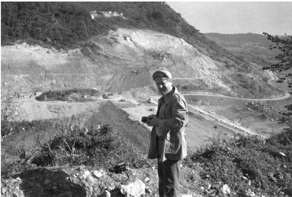
Derrumbe de la margen izquierda en la presa en construcción, Giuza, 1981
