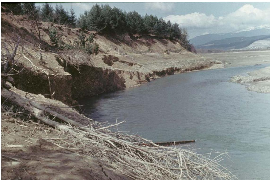
Abrasión y erosión de las orillas en embalse Orava, Eslovaquia, 1968.
