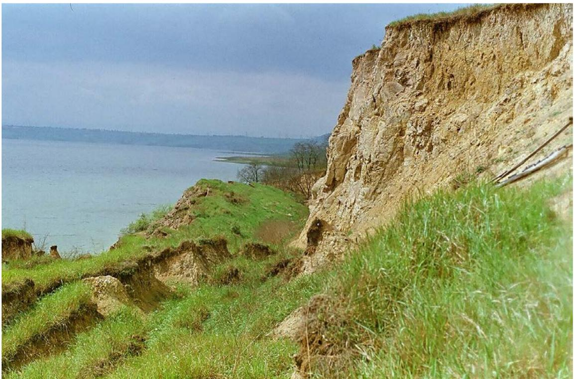
Abrasión de las orillas y consecuentes derrumbes de orillas de la presa Orava en Eslovaquia, 1968.
